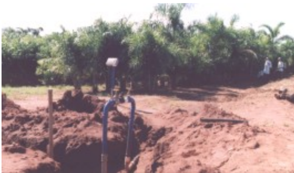
FOTO 18 - Obras de automação da área.
